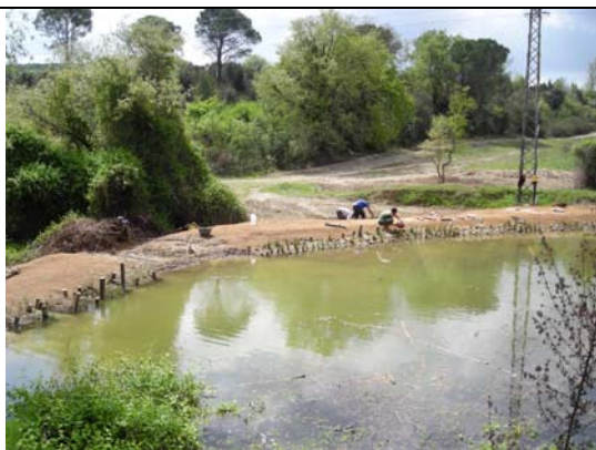
Detalls del procés d'instal·lació dels herbassars i la ret de coco, i primers temps post instal·lació.
