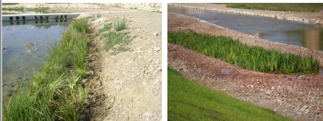
Naturalització de lleres endegades mitjançant la plantació d'herbassar pluriespecífics estructurats en fibra tipus Plant Carpet™
