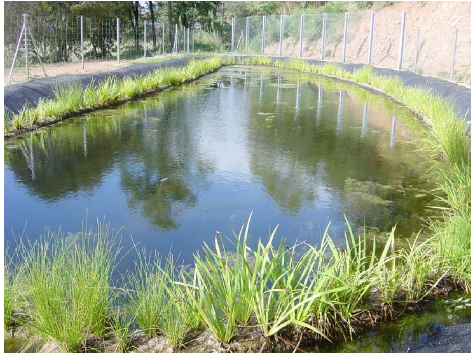
Setembre de 2003, un cop finalitzada la instal·lació.
