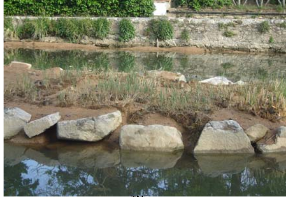
Plantació de Plant plug™ a l'escullera, i Plant pallet™ a l'illa.
