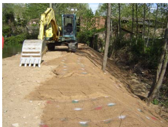
Instal·lació de la geomalla C-125BN de NAG.
