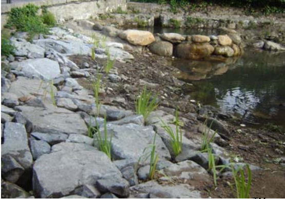
Plantació de Plant plug™ a l'escullera, i Plant pallet™ a l'illa.
