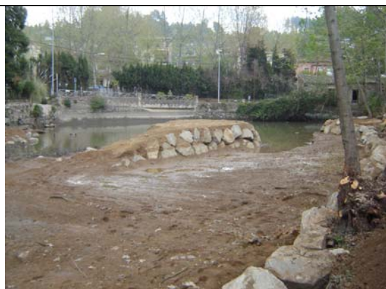
Imatge de l'obra abans de l'instal·lació
