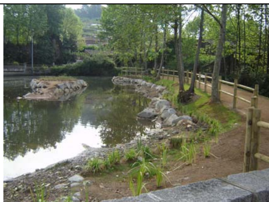
Instal·lació de Fiber roll™ vegetat.
