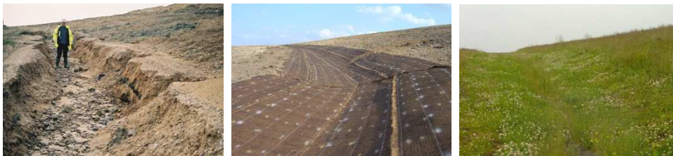
Canal de drenatge amb geomalla C350 Vmax
