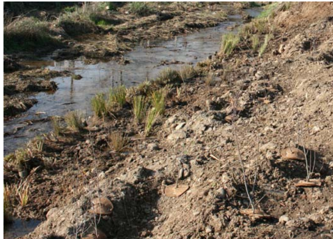
Unidades de Plant Plug™ plantados entre el Fiber Roll™ y el margen
