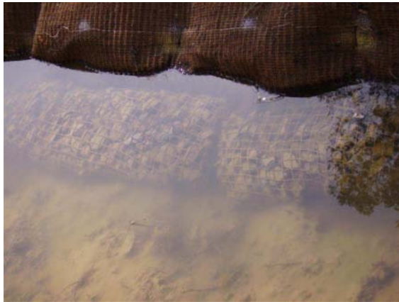
Imágenes del gavión flexible Rock Roll™ fijando la geomalla y estabilizando la base para la posterior instalación del Fiber Roll™.
