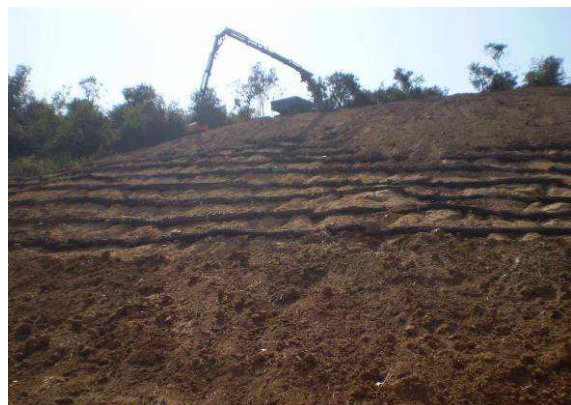
Construcción de fajas de rama seca.
