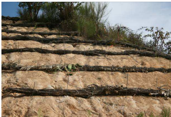
Construcción de fajas de rama seca.
